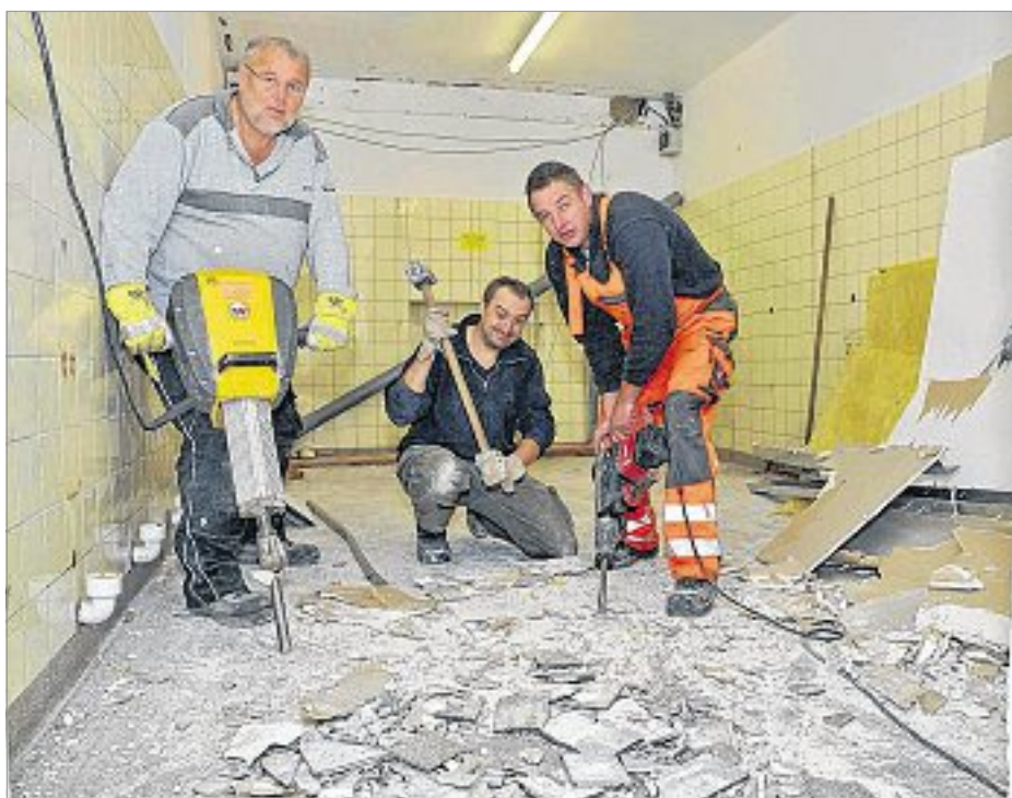
So kann eine Gemeinde Geld sparen: Ortsbürgermeister Norbert Klaes (l.) machte sich gemeinsam mit Hausmeister Sebastian Klein (r.) und Gemeindefrank Füllgraf an die Abbrucharbeiten.
