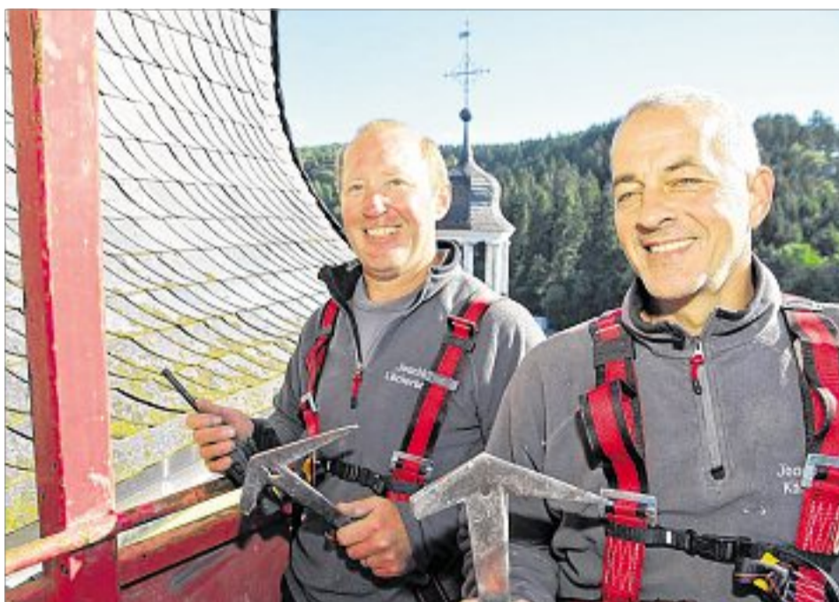
Joachim Löcherbach (l.) und Joachim Köhler machen sich bereit, die beschädigten Schieferplatten auszubessern.
