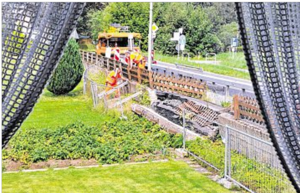
Der Blick aus dem Küchenfenster bereitet nur bedingt Freude. Dass jetzt die Straßenmeisterei vor Ort war, ist ein gutes Zeichen – bald sollen die Bauarbeiten beginnen.
