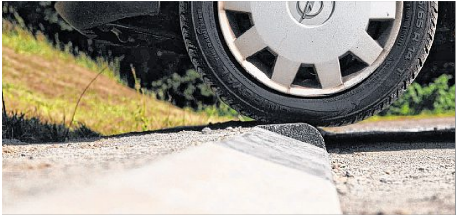
Die hohen Bordsteinkanten sollen weg; sie sollen abgeschnitten werden.
