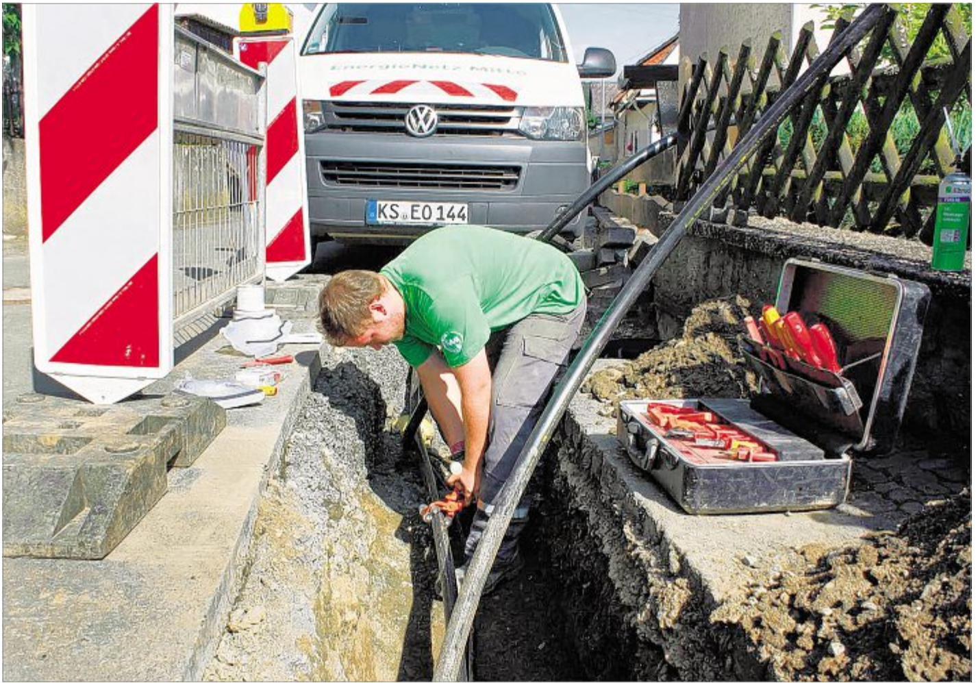
Dieses Bild werden die Menschen im Wildenburger Land in den kommenden Jahren auch in ihrem Ort sehen können: EAM plant, mehr als 20 Kilometer Erdkabel zu verlegen. Foto: EAM
